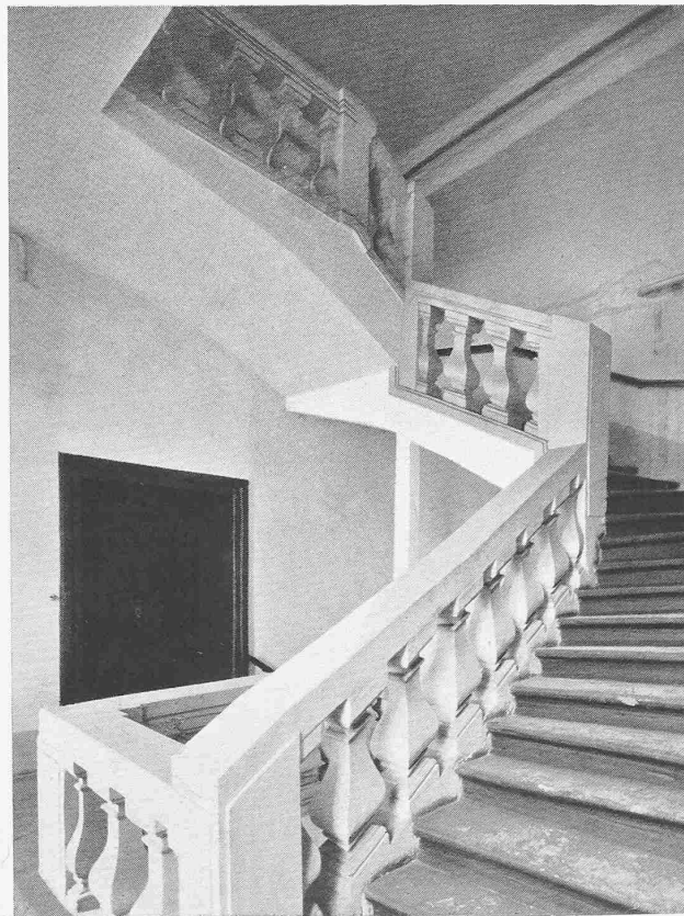
SCHLOSS STEINBRUGG, HAUPTTREPPE
