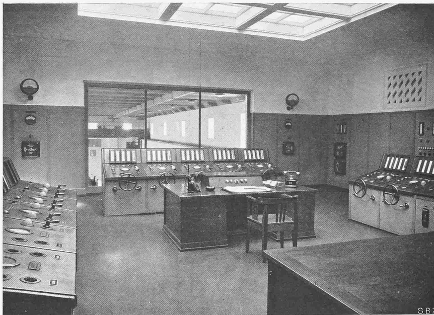
DIE ZENTRALE KÜBLIS DER BÜNDNER KRAFTWERKE ARCH. NICOL. HARTMANN & CIE., ST. MORITZ Abb. 91. KOMMANDORAUM MIT AUSBLICK GEGEN DEN MASCHINENSAAL
