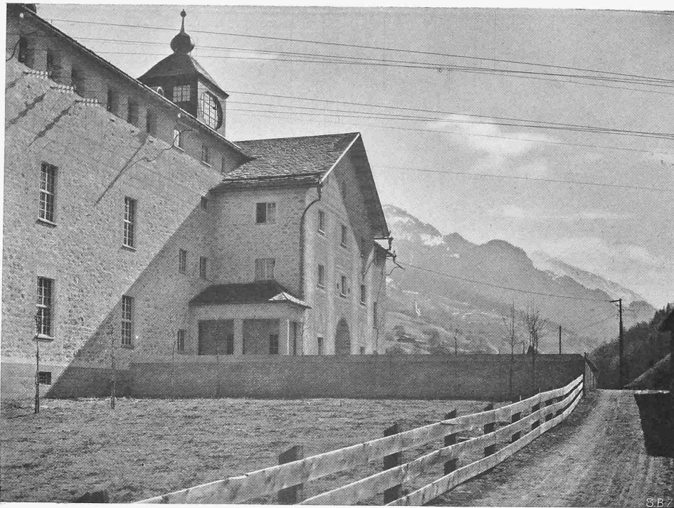
DIE ZENTRALE KÜBLIS DER BÜNDNER KRAFTWERKE ARCH. NICOL. HARTMANN & CIE., ST. MORITZ Abb. 84. SÜDFRONT, TALEINWÄRTS GESEHEN
