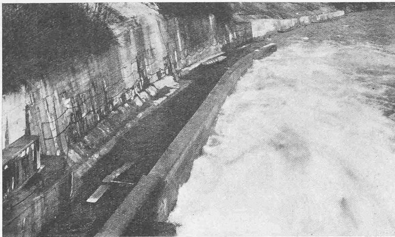
Abb 8. Ansicht der fertigen Ufermauer (Fangdamm umgelegt).
