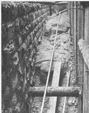
Abb. 7. Blick in die Baugrube. Rechts Fangdamm.
