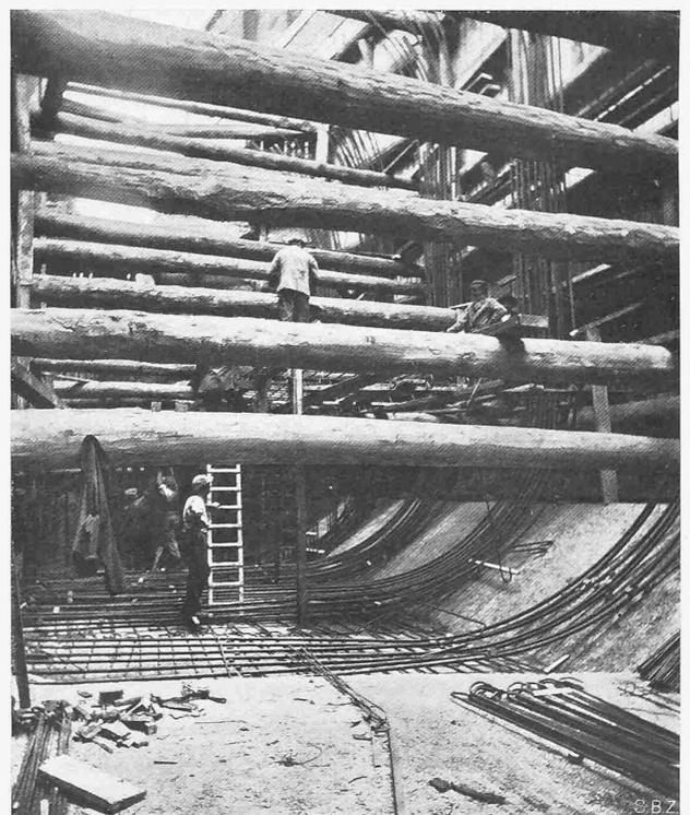
Fig. 17. Ferrailage des consoles de l'encorbellement côté Paris.
