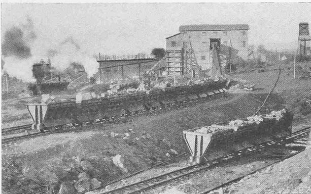
Abb. 6. Material-Aufbereitung. — Transportwagen zu 4,3 m<sup>3</sup> Inhalt.
