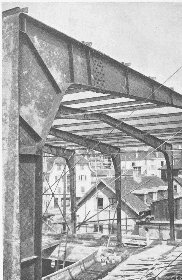
Abb. 2. Detailansicht des völlig aus Flacheisen, Breitflacheisen und Blechen zusammengeschweissten Hallenbinders.
