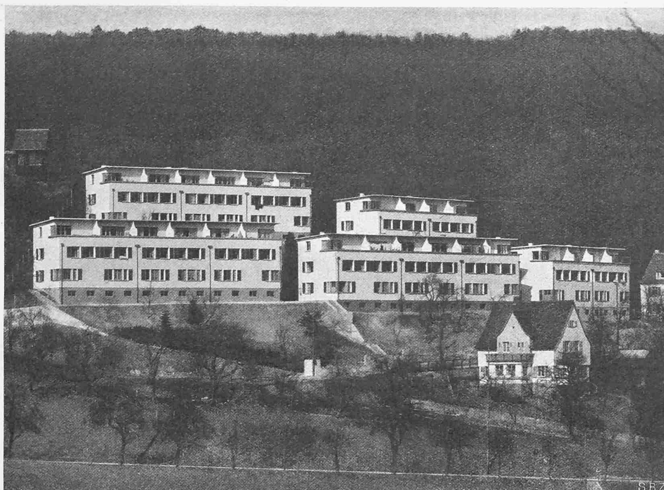
Abb. 2. Gesamtbild der Kranken-Siedlung in Stuttgart-Heslach, aus Süden.
