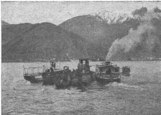
Abfahrt der Verlegeflotte in Poiana
