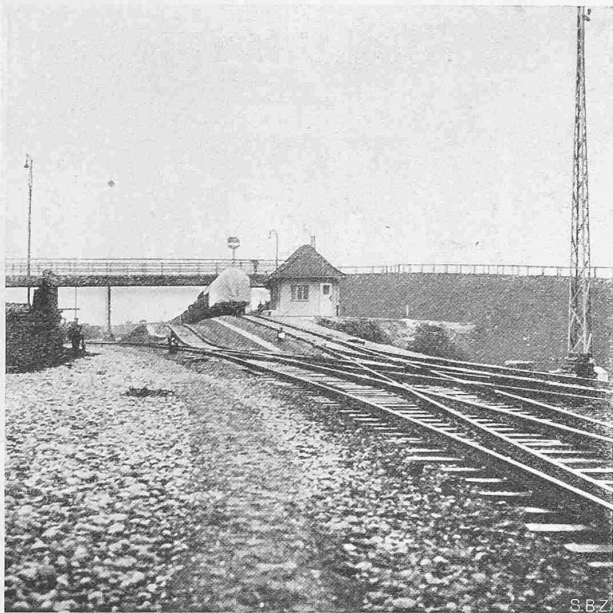
Abb. 14. Sommer- und Winterücken mit Stellwerk III.
