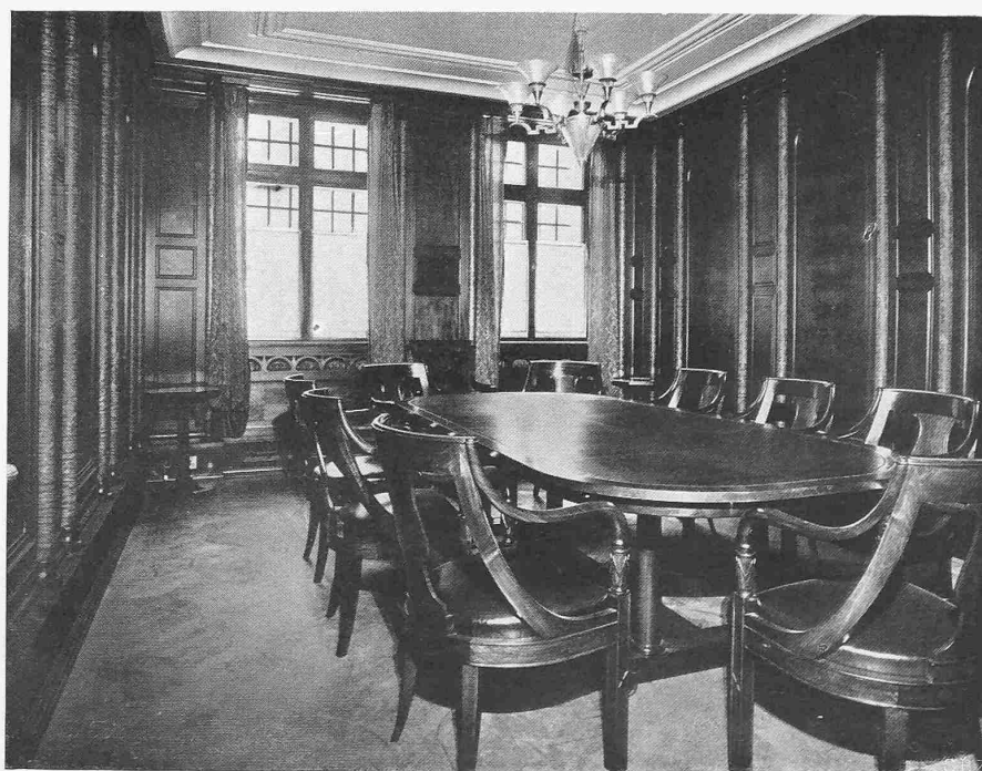
SITZUNGSZIMMER IM ERDGESCHOSS
