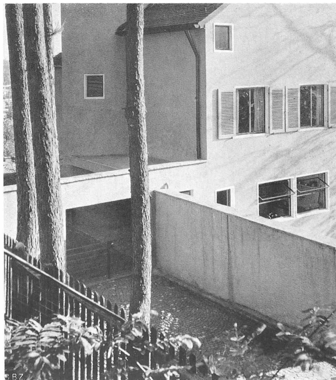
DIE RÜCKWÄRTIGE ZUFAHRT
