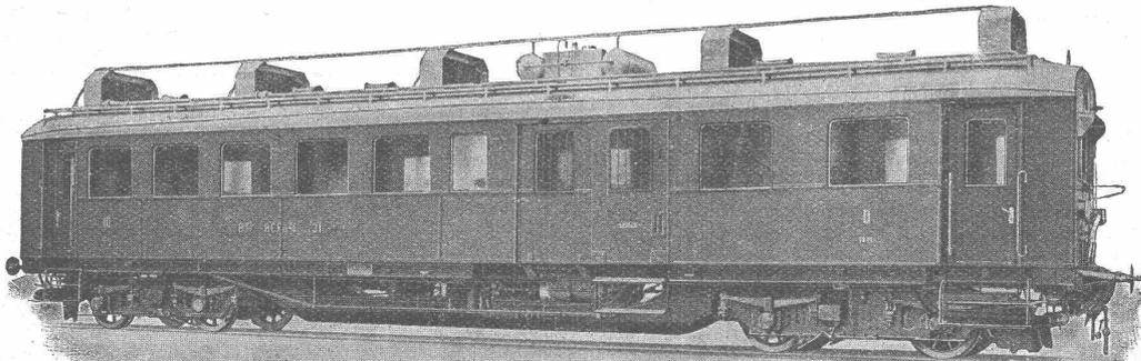
Benzin-Triebwagen der Bodensee-Toggenburg-Bahn
