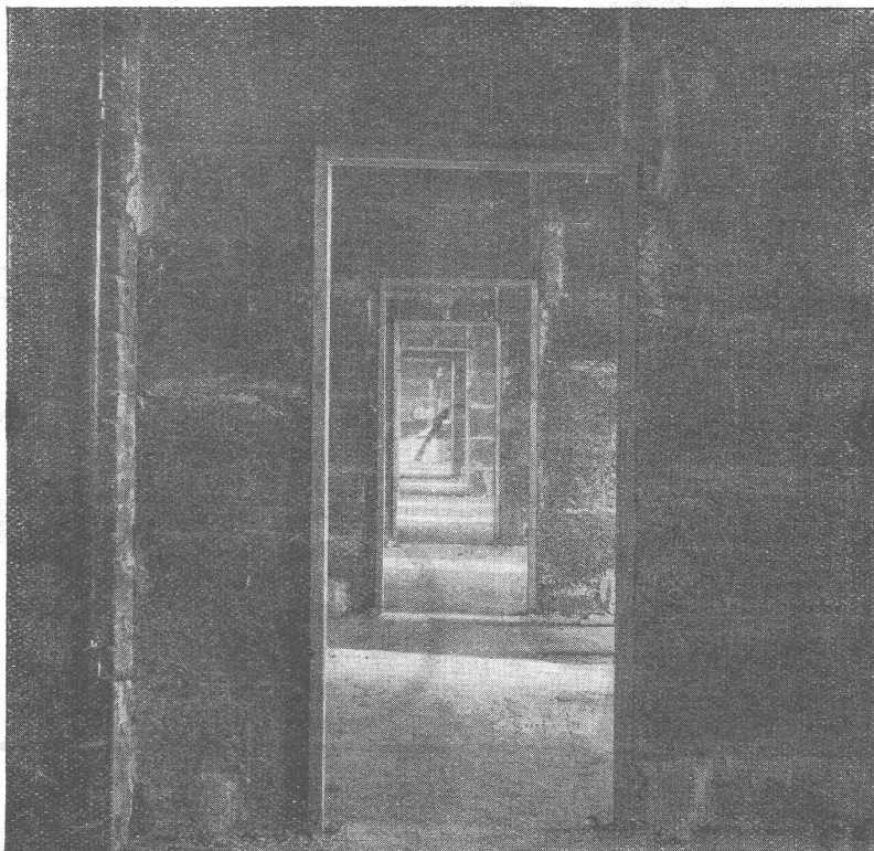
Neubau des Verwaltungs-Gebäudes der I. G. Farben-Industrie A.-G. in Frankfurt a. M. Sämtliche Zwischenwände aus Heraklith
