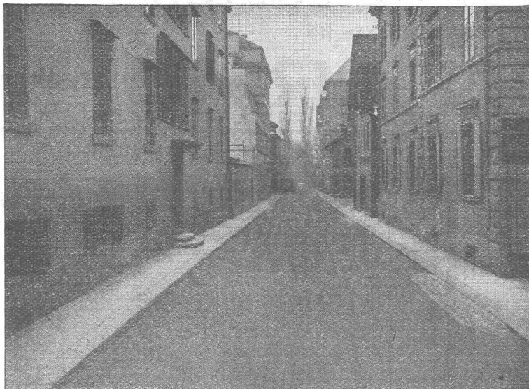
GLARNISCHSTRASSE ZÜRICH Walz-Asphalt: Topeka, 6 cm stark
