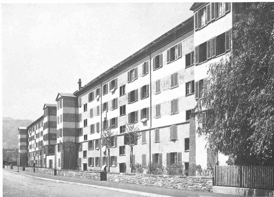
SÜDÖSTLICHE HÄUSERGRUPPE AN DER SEEBACHSTRASSE
