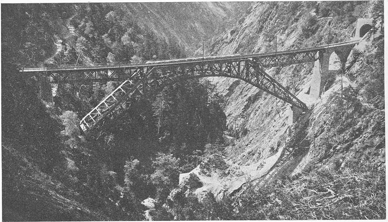
Die Bietschtal-Brücke auf der Südrampe der Lötschbergbahn. Erbaut 1912/13 von der Buss A.-G., Basel, nach Entwurf und unter Leitung von Obering. Adolf Herzog.
