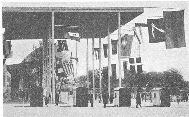
Abb. 2. Haupteingang mit Kassenhäuschen. Die eisernen Dachstützen sind verglast und nachts von innen beleuchtet.
