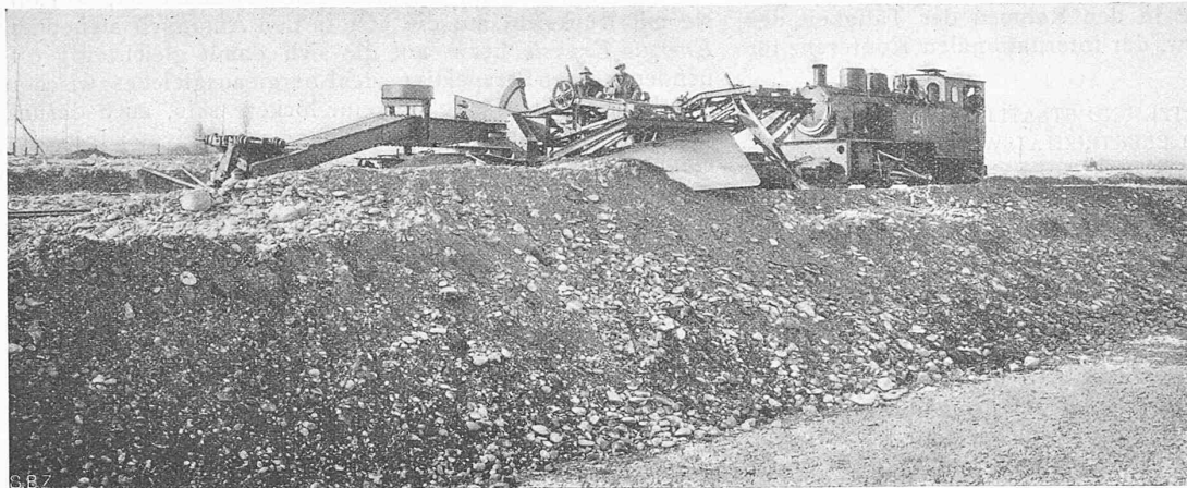
Abb. 15. Pflug- und Geleiserückmaschine der Lauchhammerwerke A.-G., als Pflug arbeitend.
