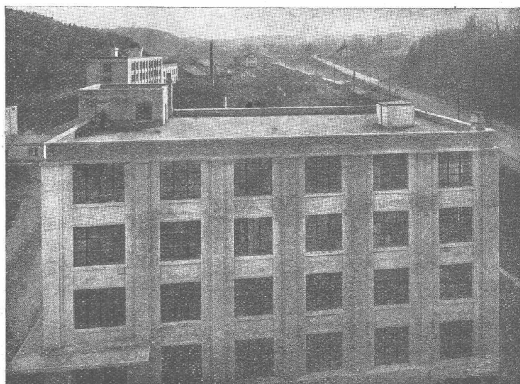
Fabrik von Maggi's Nahrungsmitteln, Kemptthal, Neubau Mühle
