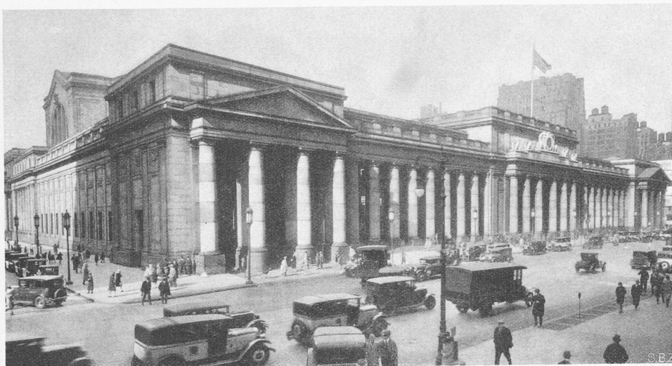
Abb. 13. Untergrund-Bahnhof der Pennsylvaniabahn in New York City.
