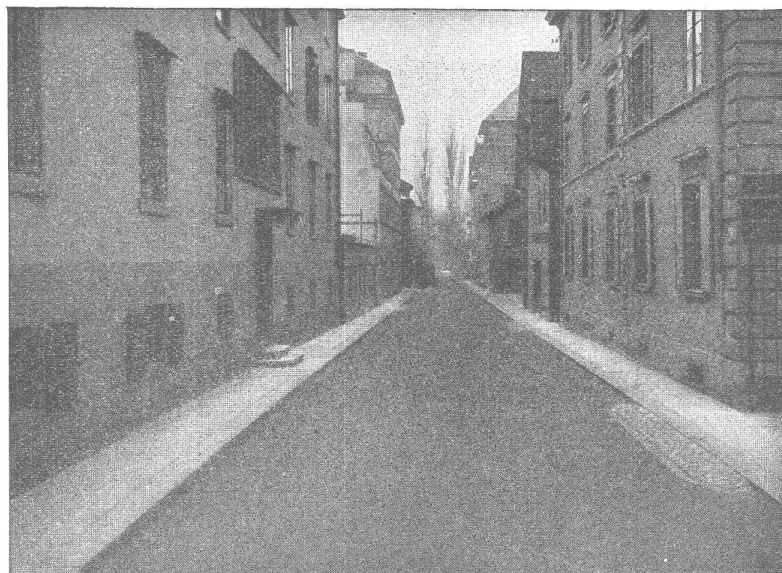
GLARNISCHSTRASSE ZÜRICH Walz-Asphalt: Topeka, 6 cm stark
