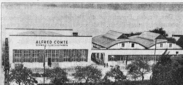
Flugzeugfabrik in Horgen 1700 m² Bitumitekt-Bedachungen grünschiefer-besandet
