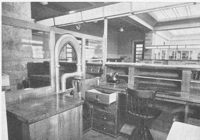
Abb. 9. Rohrpoststation am Geldschalter im Erdgeschoss.
