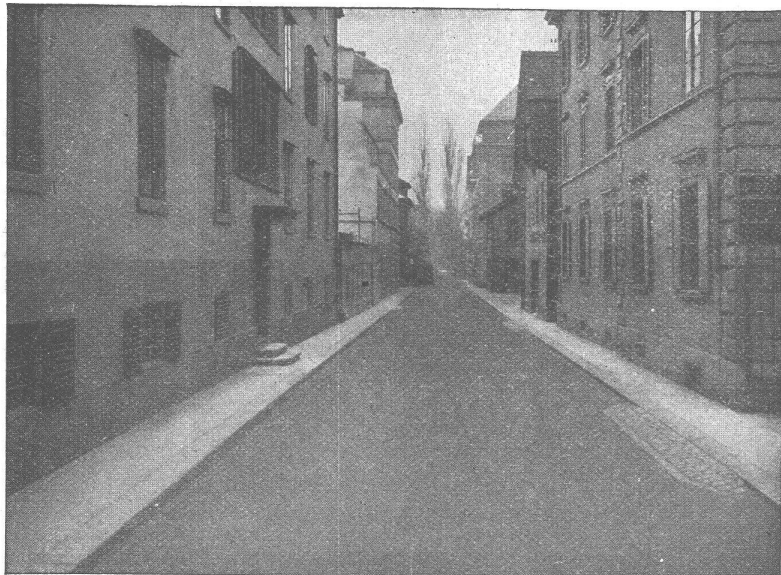
GLARNISCHSTRASSE ZÜRICH Walz-Asphalt: Topeka, 6 cm stark
