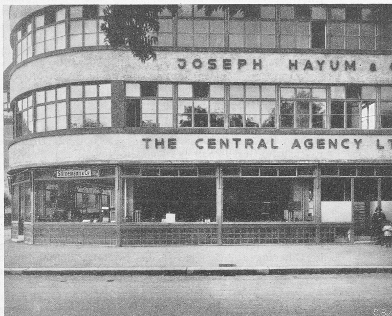
Abb. 4. Teilansicht des Geschäftshauses am Stauffacherquai in Zürich.
