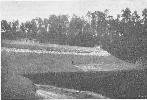
Abb. 4. Der Staudamm Zur, von der Wasserseite.
