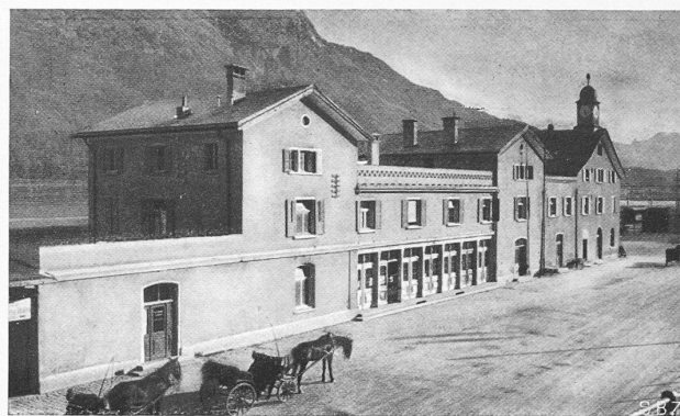
Abb. 2. Aufnahmegebäude St. Moritz im frühern Zustand
