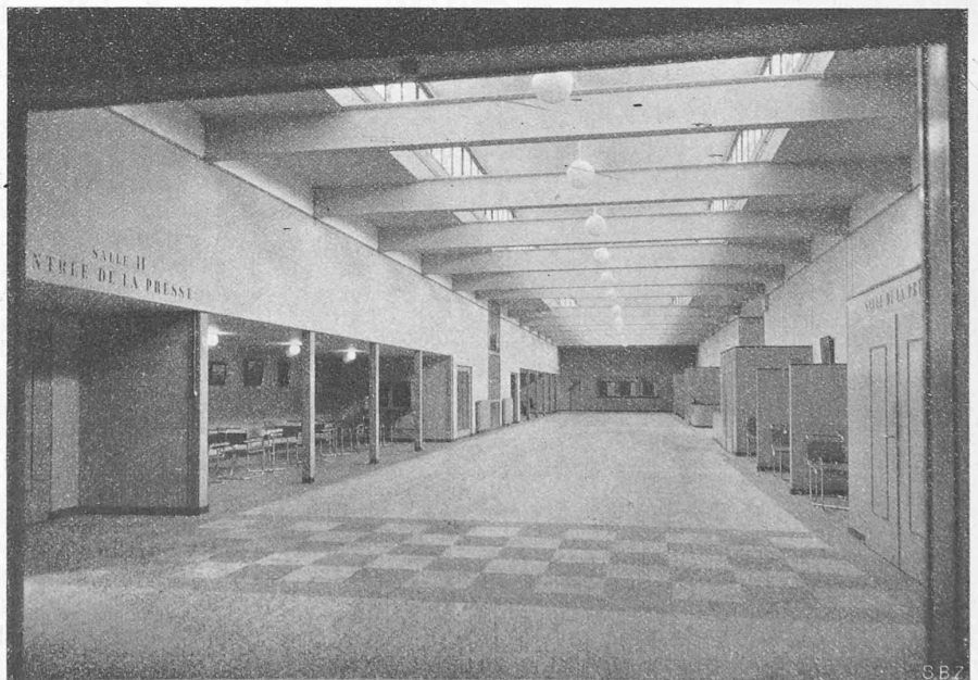
Abb. 6. Vorraum im Hauptgeschoss „Salle des pas perdus“.
