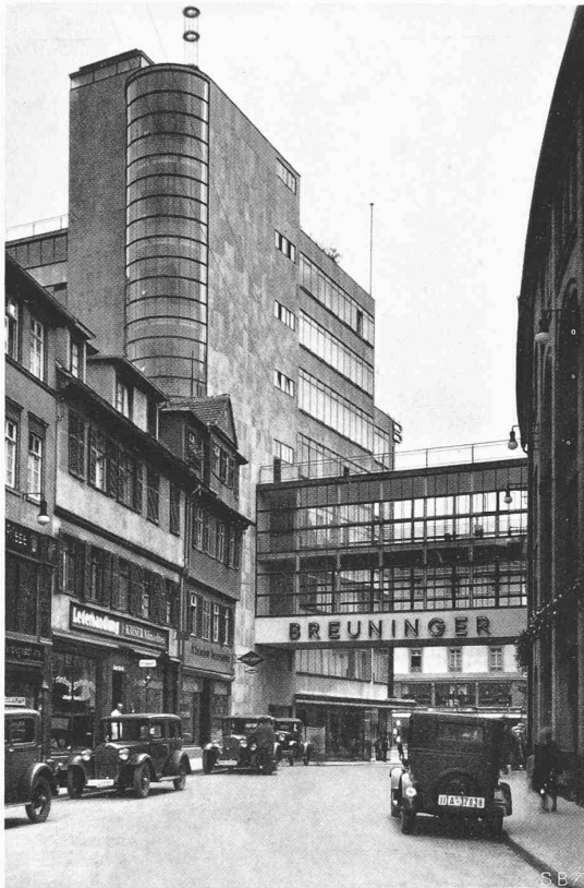
Abb. 12. WARENHAUS BREUNINGER, AUS DER KARLSTRASSE
