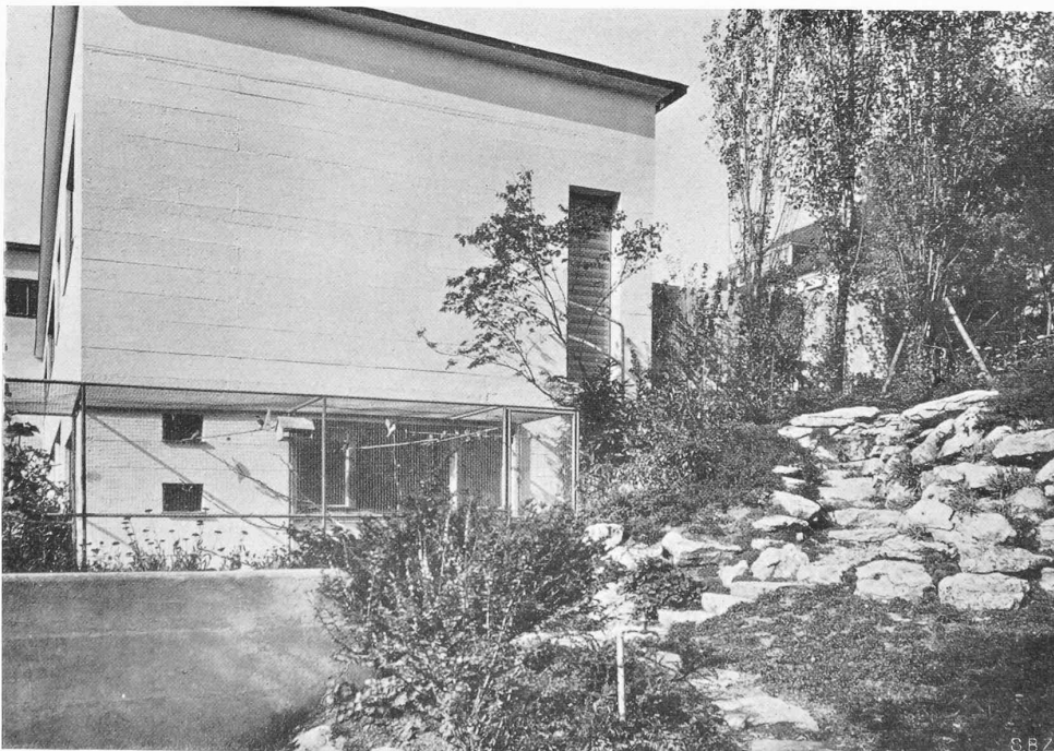
Abb. 17. SÜDÖSTLICHE STIRNWAND DES SCHMALEN STRASSENTRAKTES, RECHTS TÜR ZUR GARAGE VORN UNTEN VOLIERE FÜR ZIER- UND SINGVÖGEL
