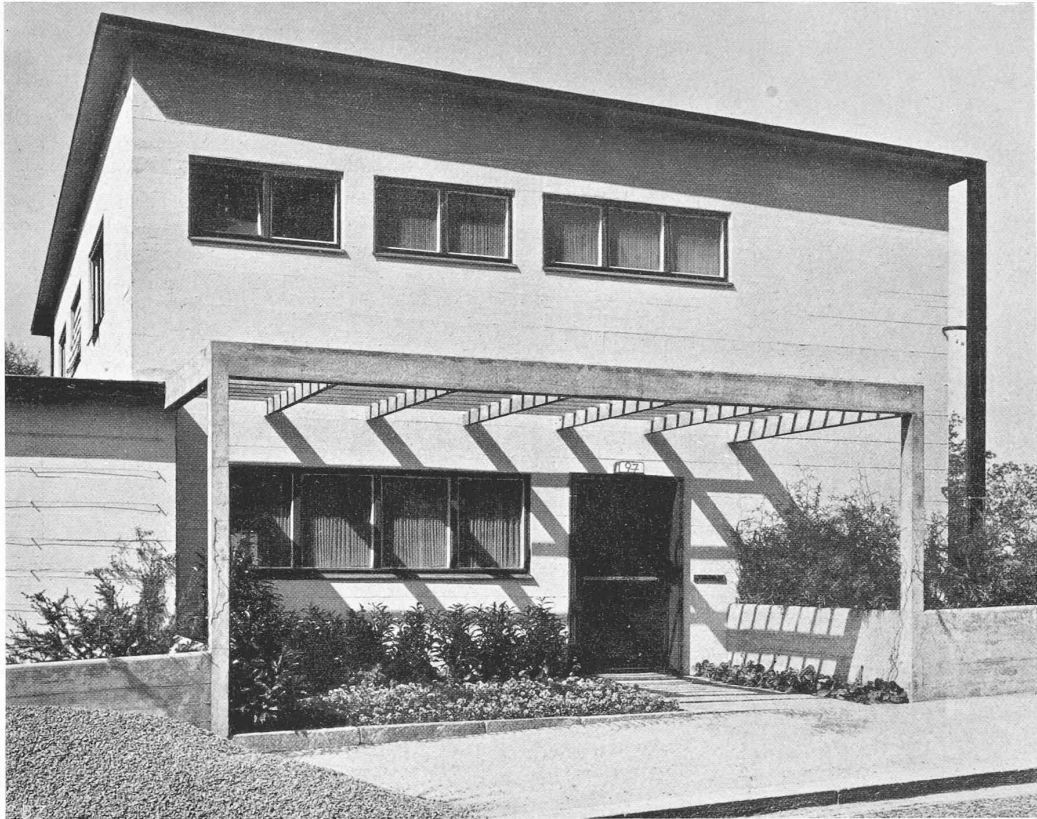
Abb. 9. NORDOSTSEITE, HAUSEINGANG AN DER RESTELBERGSTRASSE NICHT „HAUPTFASADE“, SONDERN EHER RÜCKSEITE. — PERGOLA IN EISENBETON
