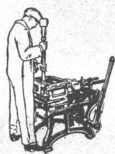
Handbedienung 300 Blöcke und Hohlblöcke od. 1500 Steine täglich
