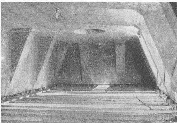
Abb. 4. Arbeitskammer eines Eisenbeton-Caisson.
