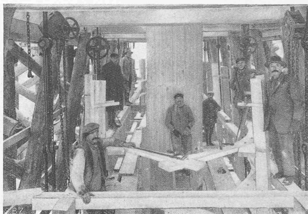
Abb. 5. Aufbau der Pfeilerschalung im Spindelgerüst.
