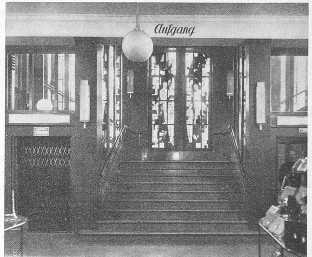
Abb. 5. Antritt der Haupttreppe zwischen den vier Aufzügen im Erdgeschoss.
