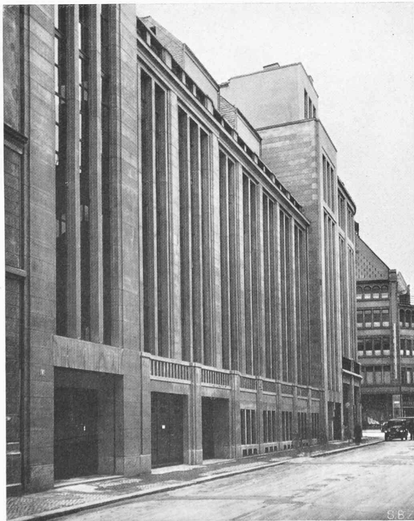
NEUBAUTEIL AN DER LINTHESCHERGASSE
