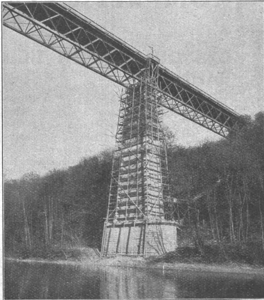
Umbau der S. B. B. Reussbrücke Mellingen. — Ausführung der Ummantelung der Pfeiler in Eisenbeton
