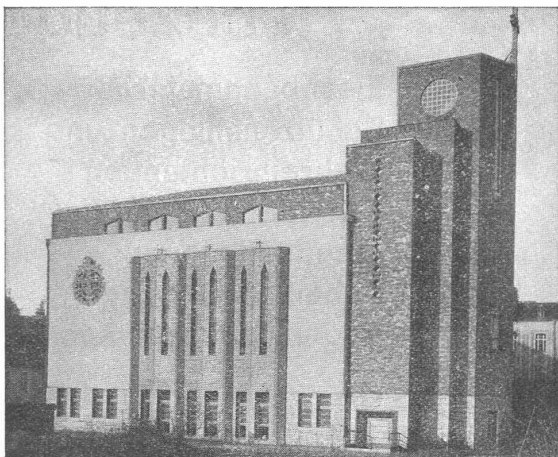
Bitumitekt-Flachdach auf einer Kapelle in T.
