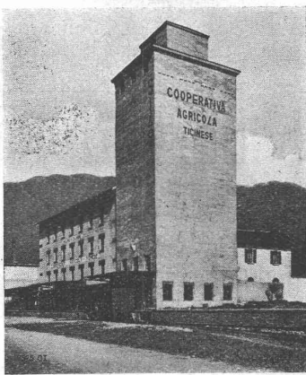
Cooperativa Agricola Ticinese, Bellinzona Silo und Mühle in Giubiasco
