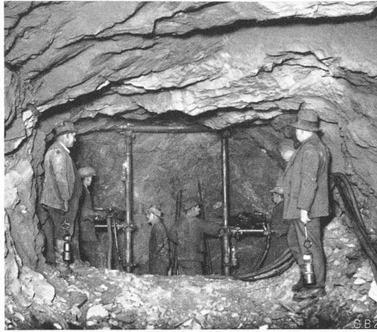
Abb. 48. Vortrieb mit 10 m<sup>2</sup> Profilfläche im Gneis.
