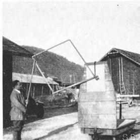
Abb. 44. Rollwagen mit Pantograph 1 : 20, zur Aufnahme der Stollenprofile.
