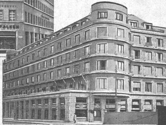
Hotel Bellerive au Lac (Apartment House), Utoquai, Zürich, ausgestattet mit 13 Frigidaire-Kühlschränken.
