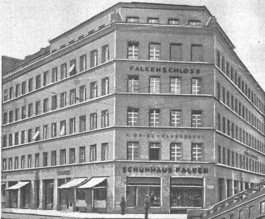
Falkenschloss, Seefeld, Zürich besitzt 14 Frigidaire - Kühlschränke und eine Frigidaire-Konditorei-Anlage.
