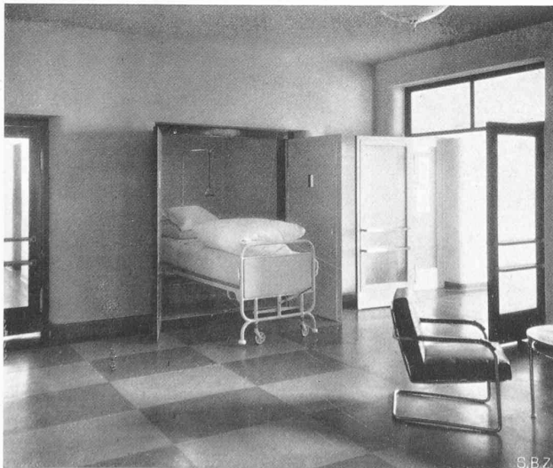
Abb. 10. Interne Verkehrshalle mit Bettenaufzug.
