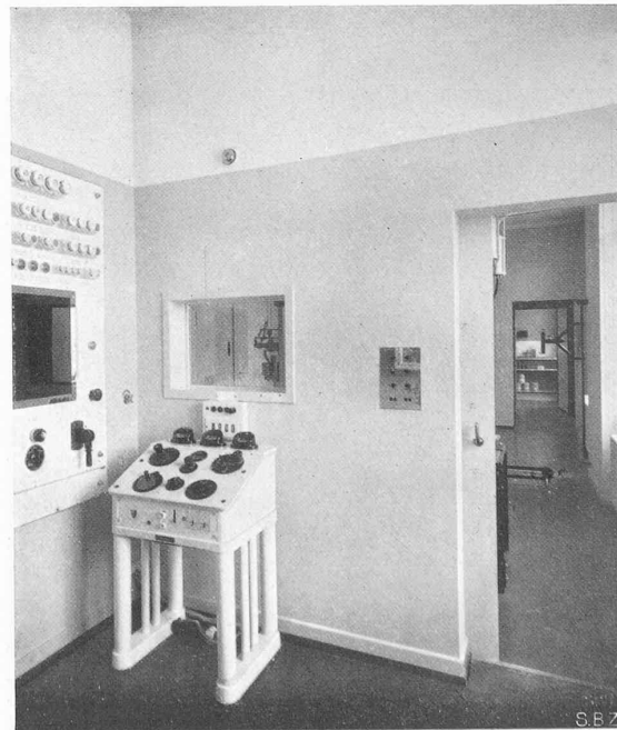
Abb. 32. Schallraum der Abteilung für Röntgen-Diagnostik, im Hintergrund die Durchleuchtungskammer.
