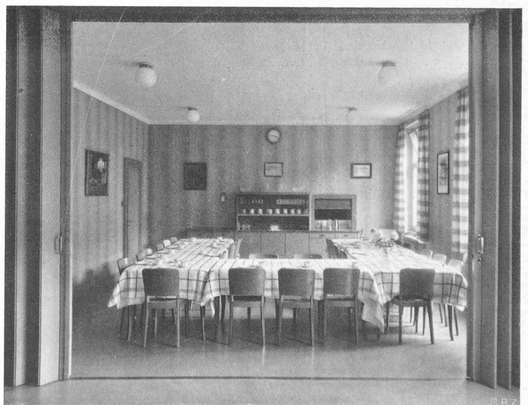
Abb. 20. Esszimmer der Krankenschwestern, Faltwand geöffnet.
