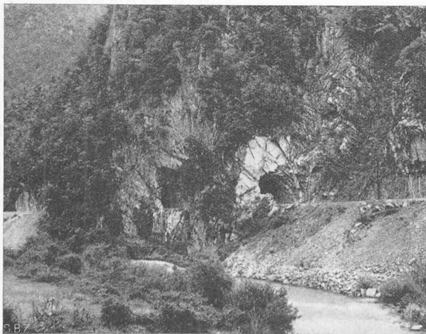
Abb. 11. Durchstich einer Felswand in zwei kurzen Tunneln bei Km. 26,3 der meterspurigen Spoleto-Norcia-Bahn.
