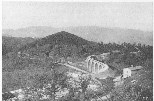
Abb. 3. Blick aus Südost auf den S-förmigen Viadukt von Caprareccia (acht Öffnungen zu je 12 m Lichtweite). Km. 7,8.
