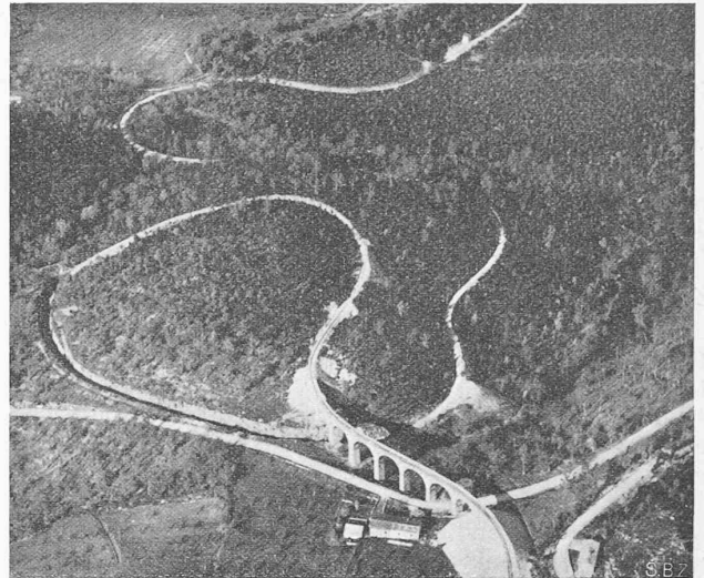
Abb. 2. Künstliche Entwicklung in offener Schleife bei Caprareccia, aus SO. Im Vordergrund (von links nach rechts) überbrückte Strasse.
