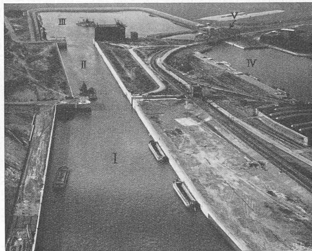
Abb. 1. Die Nordschleuse in Bremerhaven aus Süden; Tore noch im Bau.
