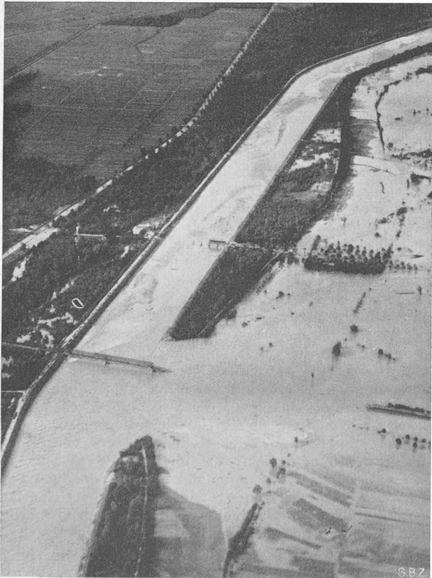
Abb. 1. Die rechtsufrige Rheindamm-Ueberflutung bei Buchs am 25. Sept. 1927. Zu beachten: die Kiesbänke im Flussbett unterhalb der Durchbruchstelle.
