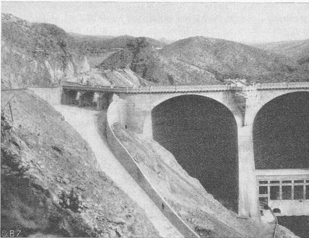
Abb. 1. Rechtsufriger Hochwasserüberlauf der Coolidge-Staumauer (U. S. A.).
