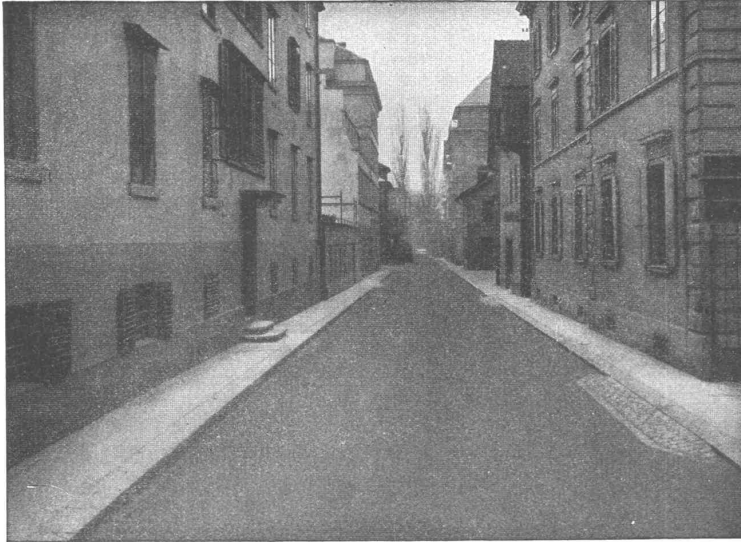
GLARNISCHSTRASSE ZÜRICH Walz-Asphalt: Topeka, 6 cm stark
