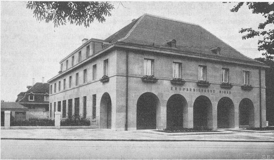
Abb. 4. Gesamtbild des neuen Sparkassengebäudes aus Osten.
