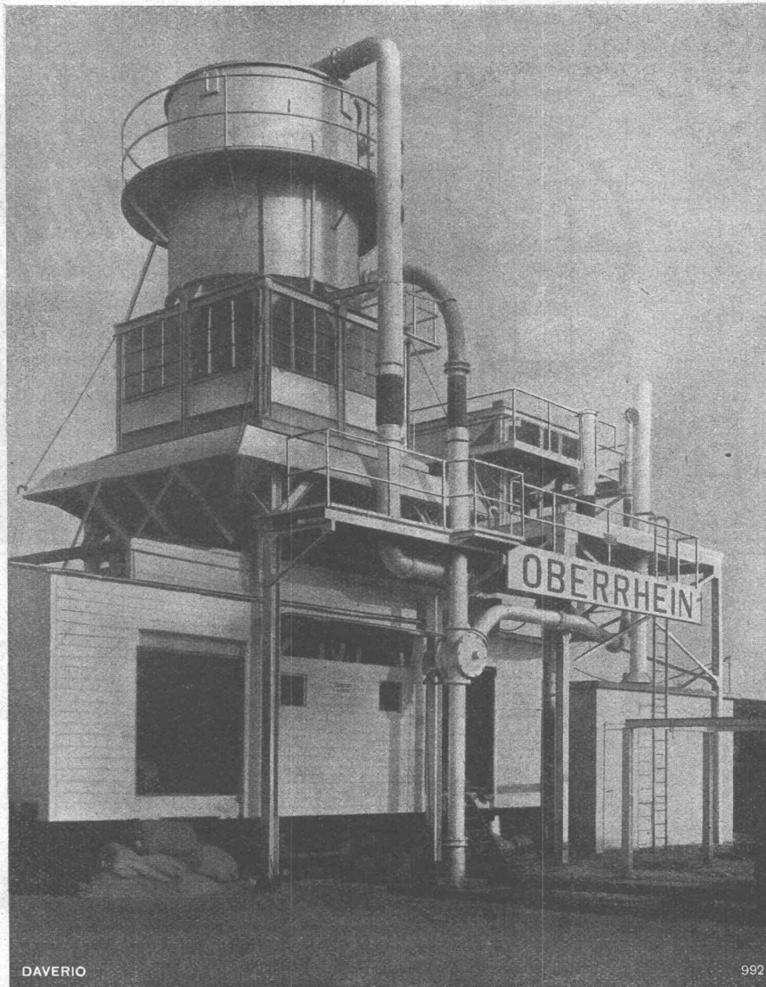
Pneumatische Schiffsentladung „Oberrhein“ Kleinhüningen (Stellung des Rezipienten für Sackverlad)
