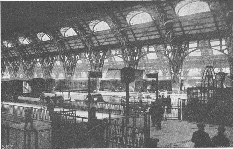
Abb. 21. Blick aus der zweiten Halle in die Mittelhalle. — Phot. A. Traldi, Milano.
