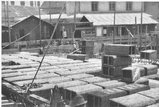
Abb. 39. Verlegte Rohrzellen.
